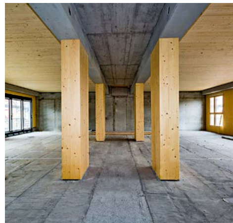
Die Bauweise des HoHos setzt auf die Stapelung vier vorgefertigter, serieller Bauelemente: Stützen, Unterzug, Deckenplatten und Fassadenelemente
