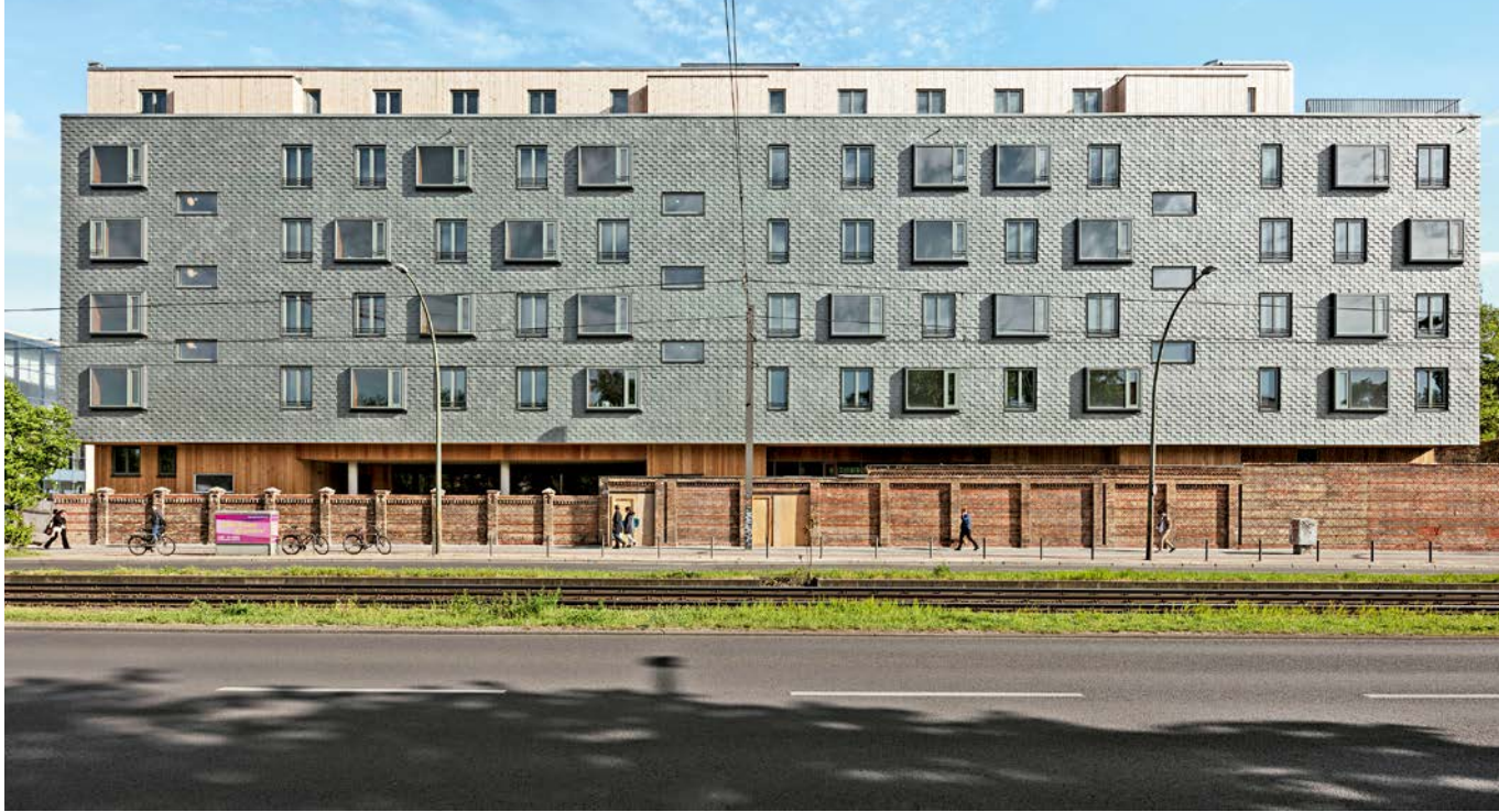
In Berlin-Friedrichshain wurde ein ehemaliges Friedhofsareal der Wohnbebauung zugeführt. Der Holzbau integriert die alte Friedhofsmauer an der Straßenseite zur 11 km langen und stark befahrenen Landsberger Allee
