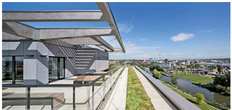
Das von Kaden + Lager Architekten geplante und im Rahmen der BUGA 2019 errichtete Skaio war zum Zeitpunkt seiner Fertigstellung mit 34 m Höhe das höchste Holzhochhaus Deutschlands
