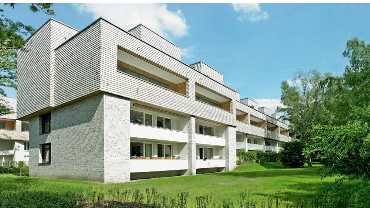
„Treehouses“ heißt dieses Projekt in der Hamburger Bebelallee. Die Aufstockung der Bestandsgebäude aus den 1950er Jahren geschah mittels Leichtbaukonstruktion in Holztafel-Fertigbauweise
