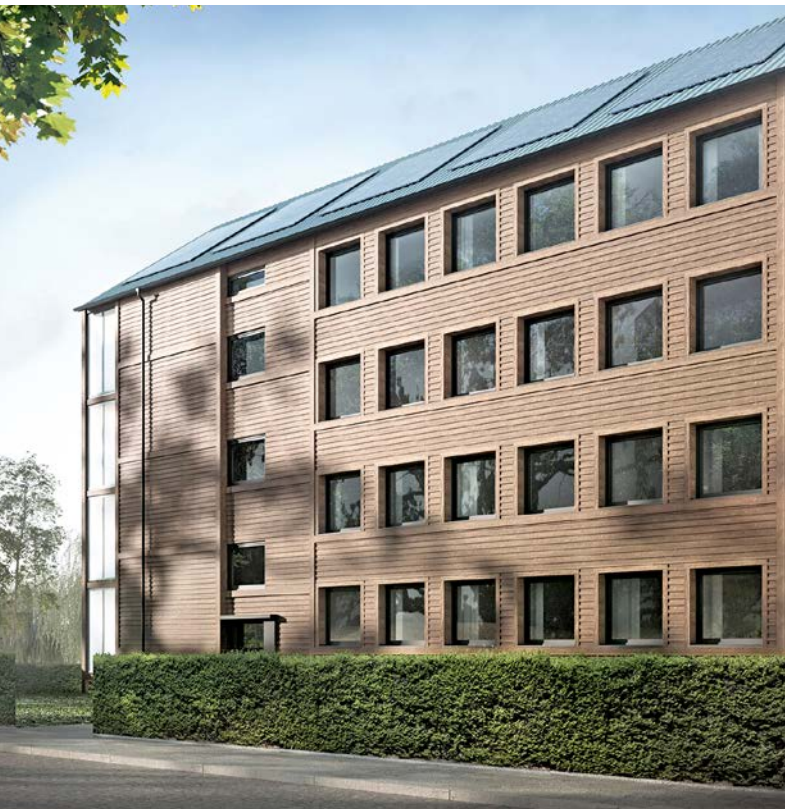
Neue Holzfassade und Dachelemente mit Photovoltaik: So sahen die Ecoworks-Entwürfe für die beiden Gebäude der WGaV aus
