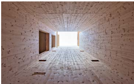
Sogar die drei Aufzugsschächte zur barrierefreien Erreichbarkeit der Wohnungen bestehen aus Brettsperrholz-Elementen
