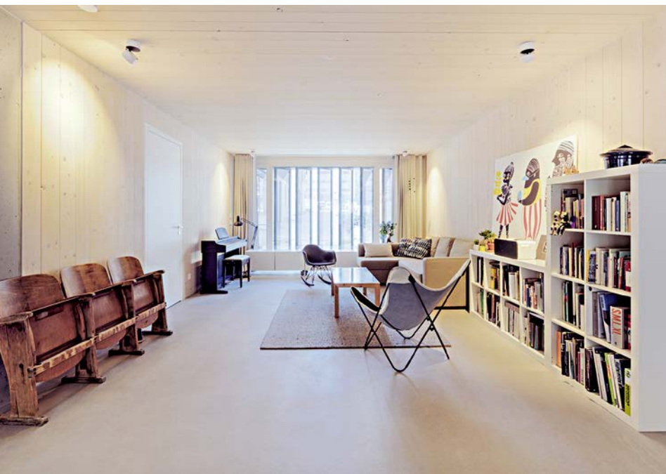
Angenehmes Raumklima, hoher Schallschutz und CO 2 -neutrale Bauweise sprechen für den Einsatz massiver Holzbauteile, hier am Beispiel des Stuttgarter Mehrfamilienhauses „MaxAcht“
