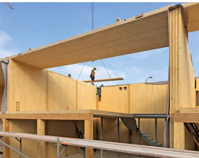
Die geforderte Feuerwiderstandsdauer (R90) für alle tragenden und aussteifenden Holzbauteile wurde über die Abbrandrate sichergestellt
