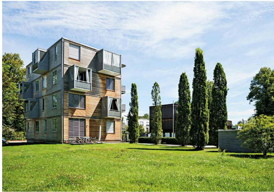
Das Bauen mit Holz ist nicht nur ein einfacher Weg, eine große Menge CO 2 einzusparen, es hat auch optisch seine Reize: hier das „Holz4“ genannte, 2010 errichtete viergeschossige Wohnhaus in der Bad Aiblinger City of Wood
