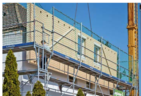
Mit nahezu komplett in der Halle vorgefertigten Modulen soll die Montage beschleunigt und durch Skalierung Kostenvorteile erzielt werden
